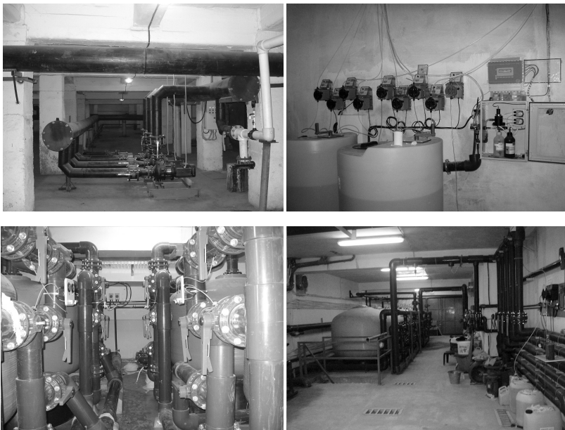
Рис. 5-8. Блок насосов в Набережных Челнах; блок дозирования химре- агентов в Ялте; блоки фильтрации в Дубаи и Лазоревском.
